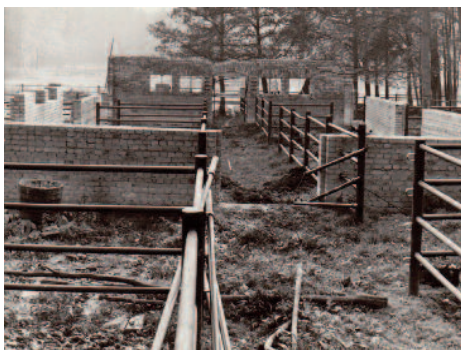
1967 – Bau der Rinderstallungen
