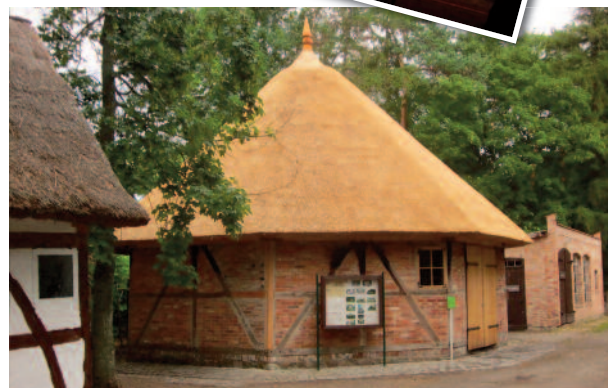
Göpelscheune wieder aufgebaut (nach Brand 2013)
