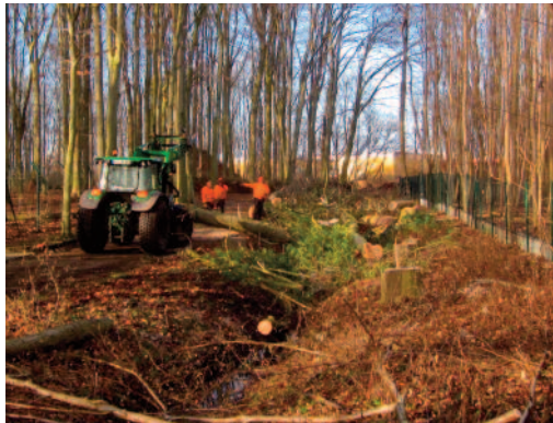
2017 – Baumpflegearbeiten am Wolfsgehege
