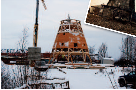
Baubeginn Mahnkessche Mühle, oben historisches Foto von 1935
